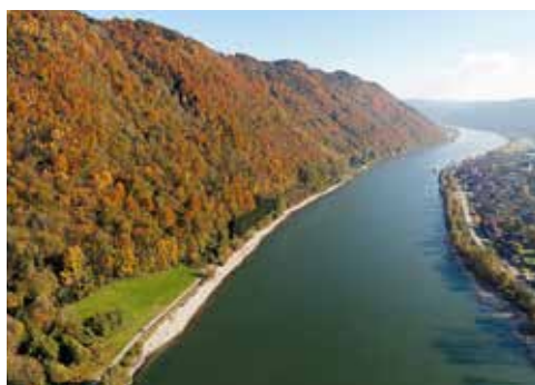
Abbildung 1: Vorgeschüttete Kiesbänke, wo vorher steile, mit Blockwurf gesicherte Ufer vorherrschten.
