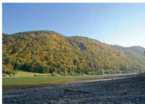
Abbildung 1: Vorgeschüttete Kiesbänke, wo vorher steile, mit Blockwurf gesicherte Ufer vorherrschten.
