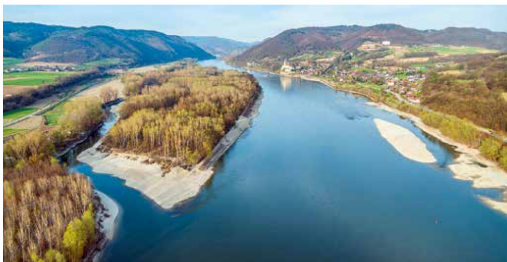
Abbildung 4: Kiesstrukturen und neu errichteter, durchströmter Nebenarm bei Schallemmersdorf – Schönbühel.
