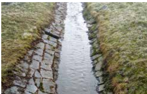
Abb. 2: Gestalt des gepflasterten Gerinnes vor Rückbau. Links: frisch geräumt; Rechts: bewachsen, Zustand bei der Vorerhebung.
