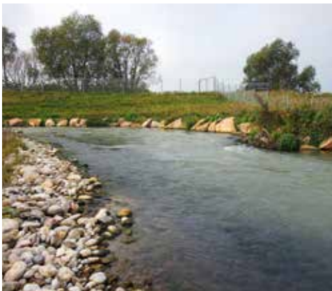
Abb 12: Flachufer eines asymmetrischen Raugerinnes am Beispiel des Verbindungsbauwerks Flutmulde Machland / Au a. d. Donau
