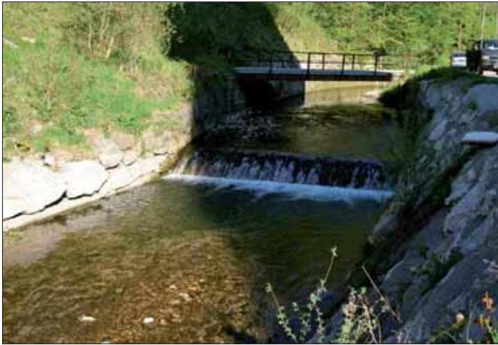
Abb. 10: Links: Eingestaute und hart verbaute Mündung des Laussabachs in die Enns mit für Strömer unpassierbarer Schwelle
