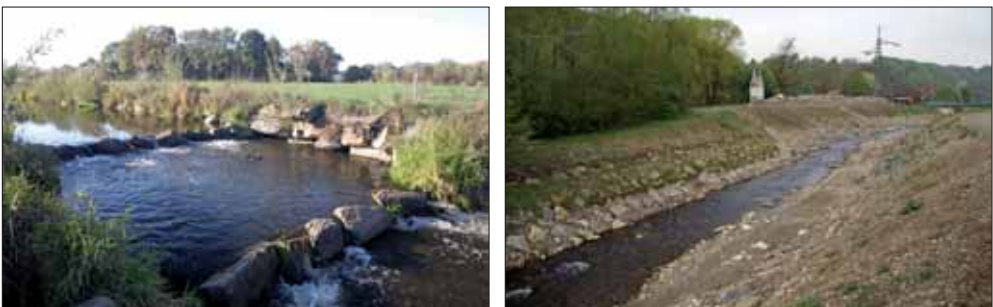
Abb. 9: Links: Obere Riegelrampe an der Leitenbach-Mündung; rechts: asymmetrische Rampe, die auch für Goldsteinbeißer passierbar ist (Gamlitzbach-Mündung, Südsteiermark)
