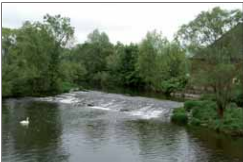
Abb. 8: Links: Aschach-Wehr in Hacking mit integrierter Fischaufstiegshilfe, die für Goldsteinbeißer und andere Arten als nicht passierbar einzuschätzen ist. Rechts: Beispiel für ein rückgebautes Wehr an der Pram bei Heitzing
